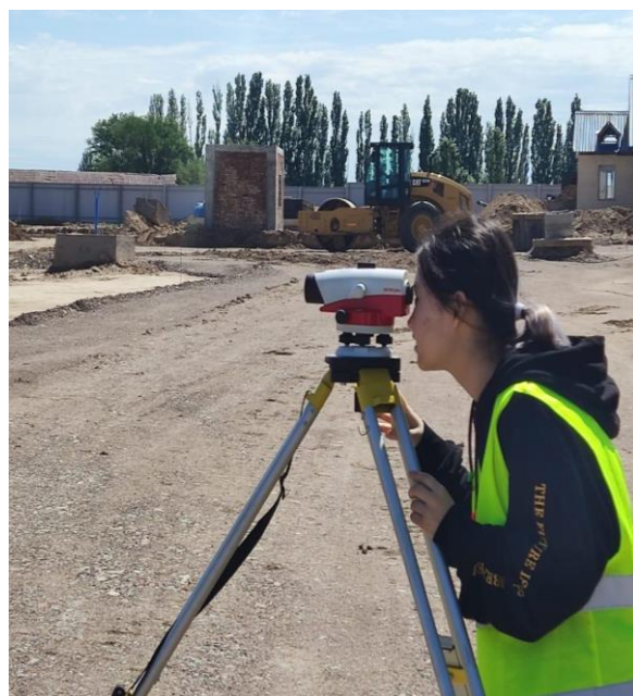
9 Сурет - Геодезиялық реперлер бойынша Leica NA720 нивелирымен жұмысты орындау
