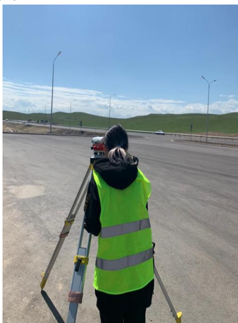
9 Сурет - Геодезиялық реперлер бойынша Leica NA720 нивелирымен жұмысты орындау
